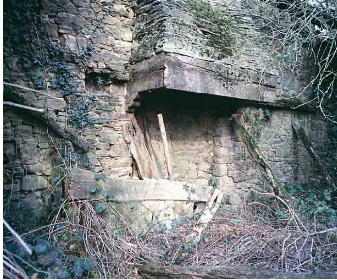
Fig. 14 - Sion-les-Mines, cheminée à faux manteau de bois d'un logis en ruine de l'alignement du Petit-Lorais, XVIIIe siècle. Photo Bernard Renoux, droits réservés.
