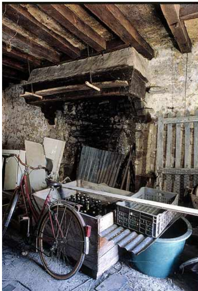
Fig. 15 - Sion-Les-Mines, cheminée à faux manteau de bois d'un logis sans fenêtre de l'alignement de la Riodais, fin XVIIIe ou début du XIXe siècle. Photo Bernard Renoux, droits réservés.
