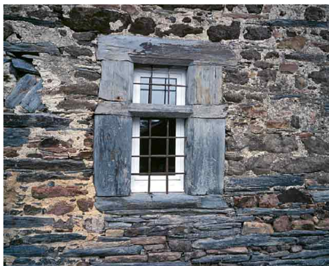
Fig. 11 - Marsac-sur-Don, alignement de la Colle, détail, baie à meneau d'un logis de paysan aisé, première moitié du XVIIe siècle. Photo Bernard Renoux, droits réservés.
