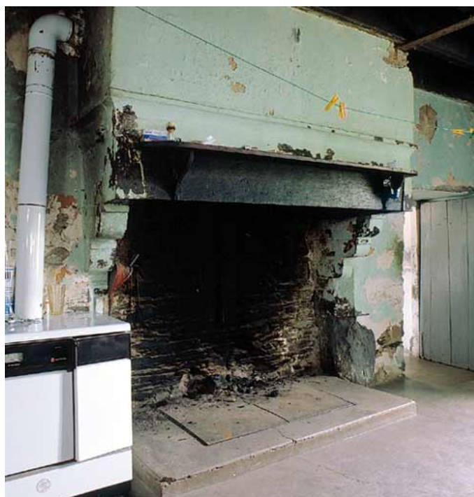
Fig. 13 - Derval, le Coudray, cheminée à faux manteau de schiste de la salle du logis seigneurial, XVI e siècle. Photo Bernard Renoux, droits réservés.
