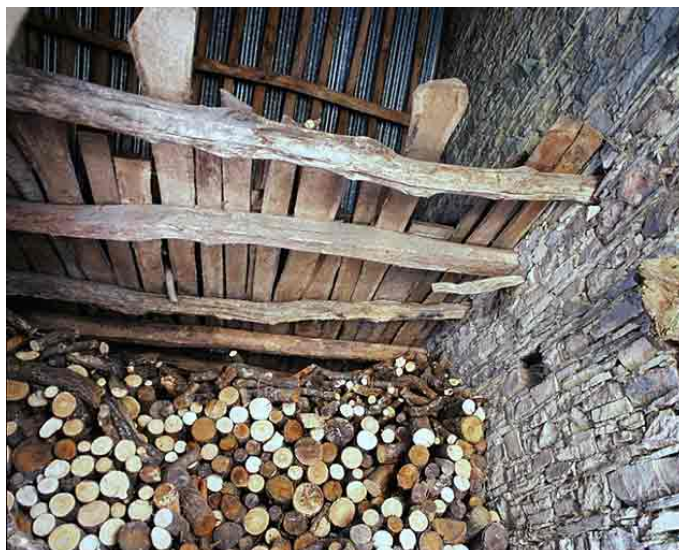
Fig. 16 - Sion-les-Mines, alignement de la Riodais, étable doublée de perches, première moitié du XIXe siècle. Photo Bernard Renoux, droits réservés.
