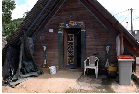
Fig. 13 - Maison aluku à Apatou. Cette construction récente, plus vaste et plus haute que les maisons traditionnelles, a été réalisée en lambris industriel mais a conservé la forte pente de toiture et l'auvent. Il n'y a plus de rupture entre le pignon proprement dit et le reste de la façade, mais des éléments du décor traditionnel ont été repris : la frise peinte à la périphérie de la façade, le tembé peint sur la porte et le linteau, les deux éléments verticaux qui imitent les faux pilastres placées à la verticale des pannes des constructions plus anciennes représentent le motif Kelewa , symbole du corps féminin, souvent utilisé dans les pignons des maisons de femme. Phot. Inv. M. Heller © Inventaire général, ADAGP, 2001.
