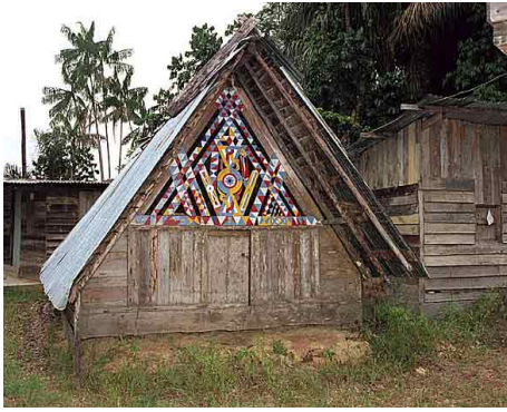
Fig. 16 - Une maison aluku de Loka (hameau de Papaïchton). Le remplissage du pignon en planches découpées, ajourées et peintes comporte en son centre le motif Kelewa qui représenterait le corps féminin, la porte est sculptée d'un motif d'entrelacs dit tembé , peu visible sur cette photo. A droite et derrière, des constructions contemporaines. Phot. Inv. M. Heller © Inventaire général, ADAGP, 2001.
