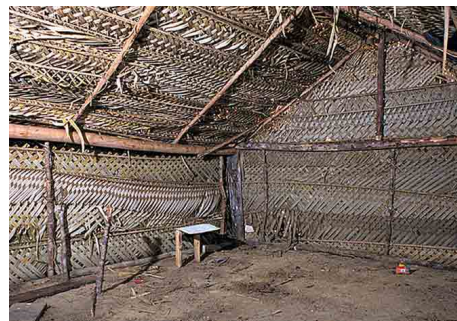
Fig. 19 - Construction en feuilles de waï dans un campu . Vue intérieure. Phot. Inv. M. Heller © Inventaire général, ADAGP, 2001.
