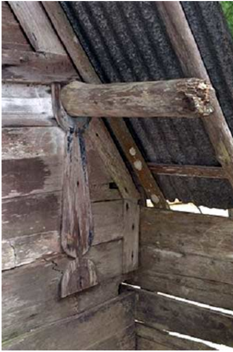
Fig. 14 - Détail de construction : le pignon repose sur les pannes intermédiaires elles-mêmes soulignées par des pièces de bois découpé en forme de balustre. Phot. Inv. M. Heller © Inventaire général, ADAGP, 2001.
