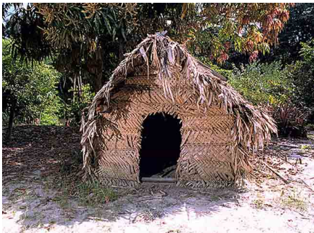
Fig. 18 - Construction en feuilles de waï dans un campu . Vue extérieure. Phot. Inv. M. Heller © Inventaire général, ADAGP, 2001.
