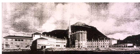
Fig. 8 : Voreppe, chapelle de l'ancien séminaire. Vue extérieure. Reproduction d'une illustration de la revue L'Art Sacré , n° 5, 1935, p. 21
